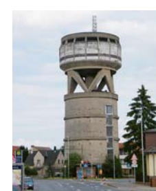
Wasserturm in Misburg
